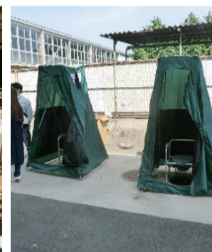
マンホールトイレ
