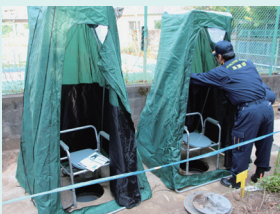
災害用トイレの設置(昨年)
