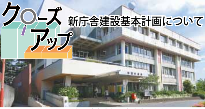
現在の清瀬市役所本庁舎
