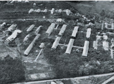
上空から見た府立清瀬病院
