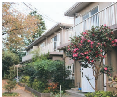
入所者が生活する家。テラスハウスのように部屋が区切られている
