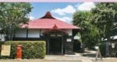
③ふれあい下水道館 誰でも自由に本物の下水道管に入ることができる日本唯一の施設
