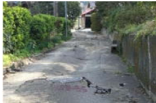
〔管路の破損による道路陥没〕
