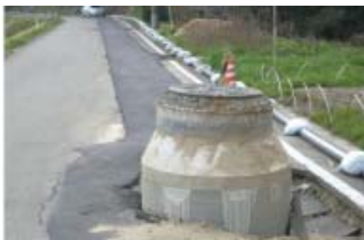
〔液状化による人孔浮上被害〕
