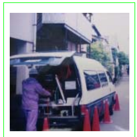
テレビカメラ調査状況写真
