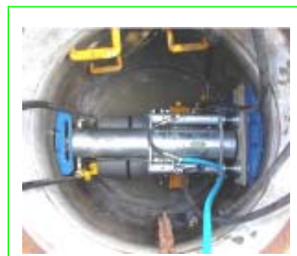
管口耐震化施工写真（他市）
