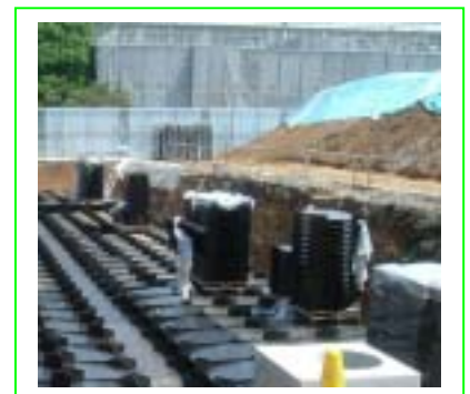
雨水貯留浸透槽施工写真（他市）
