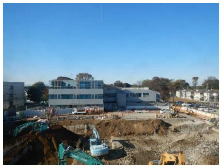
11月15日 地上部の解体が完了し地下の解体を行っています。 ※新庁舎3階から撮影
