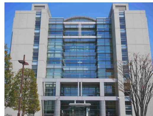
ガラスカーテンウォールで正面性を演出した事例 ／あきる野市庁舎（東京都）
