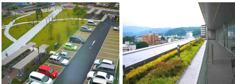
芝生緑化による広場や駐車場・屋上緑化（青梅市庁舎）
