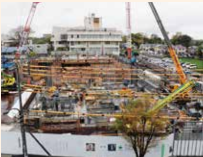
工事全体写真(4月20日時点)
