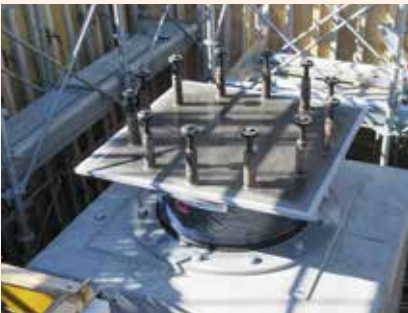
支承材(アイソレーター)の設置状況
