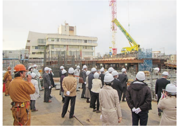
現場視察の様子
