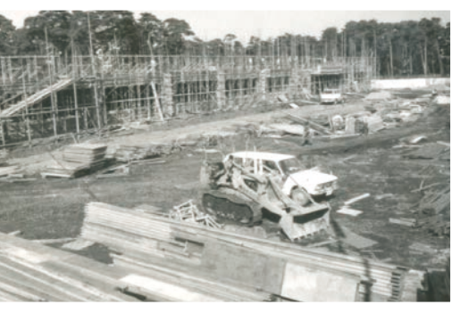
月に開校した第六小学校に次いで、人口が急増している松山・竹丘地区に第七小学校の建設がすすむ
