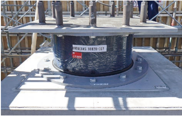
建物を支える免震部材
