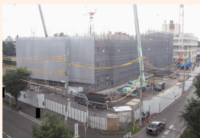
工事全体写真(令和2年6月現在)
