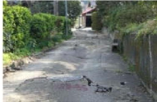
〔管路の破損による道路陥没〕
