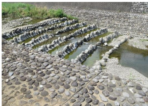
合流点すぐ上流の落差工
