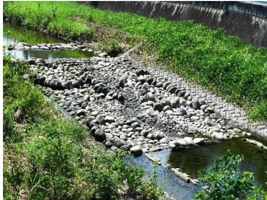
1 基目のステッププール型落差工
