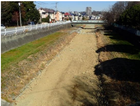
丸石を組んだ土の見える低水護岸
