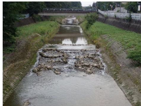
石田橋に造られた落差工
