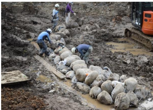
下流の4本目は親水階段前 流路断面一杯に下流に向けて〰型に作ります。(弧の中側が下流を向く)
