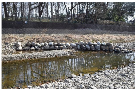
6本目、見事に上流から写すと沢山の砂礫を受け止めています。バープ工を挟んで下流に深い淵ができています。魚がいるのでしょ多種の水鳥が見られ、カメラマンが狙っています。
