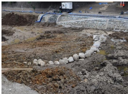
下流の4本目は親水階段前 流路断面一杯に下流に向けて〰型に作ります。(弧の中側が下流を向く)
