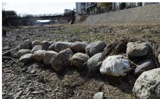
6本目、見事に上流から写すと沢山の砂礫を受け止めています。バープ工を挟んで下流に深い淵ができています。魚がいるのでしょ多種の水鳥が見られ、カメラマンが狙っています。
