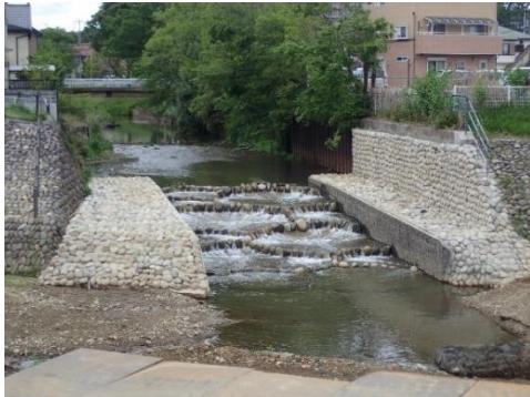
清瀬橋に造られた落差工
