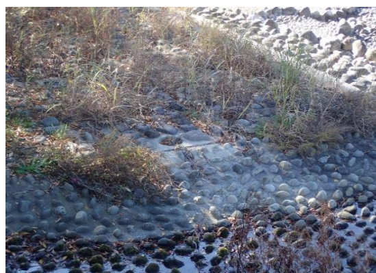
ブロックで護床された高水敷、歩きにくく危険な場所になっている
