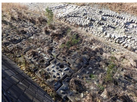
ブロックで護床された高水敷、歩きにくく危険な場所になっている
