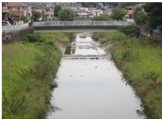
隙間のある石を張り付けた低水護岸、3年も経つと植物で覆われます
