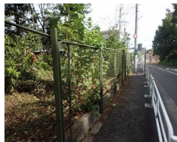
整備した道路側
