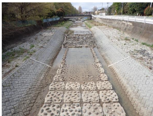
コンクリートブロックで施工された低水護岸、植物は全く生えません
