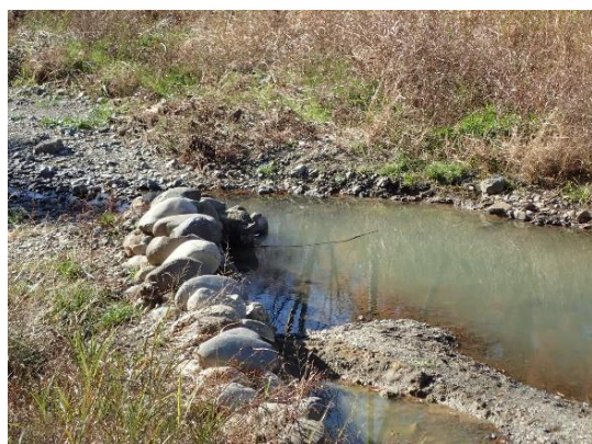
粘土層が掘られてしまったバープ工と埋まってしまったバープ工
