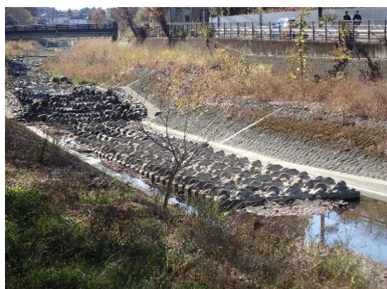
水の落ち口の護床ブロックが突出して水流をふさぎ、両サイドに水が分流している
