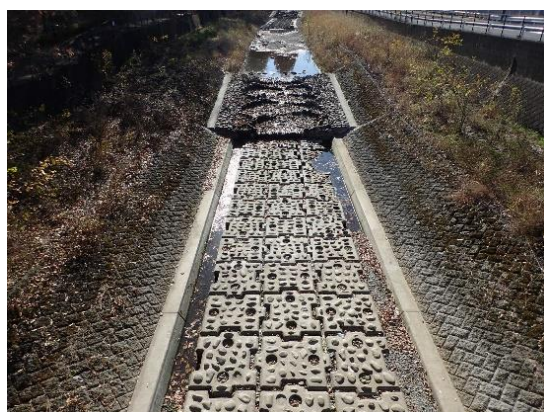
水の落ち口の護床ブロックが突出して水流をふさぎ、両サイドに水が分流している
