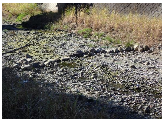
粘土層が掘られてしまったバープ工と埋まってしまったバープ工
