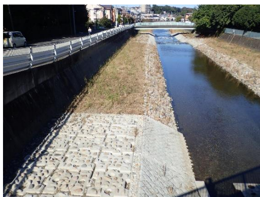
隙間のある石を張り付けた低水護岸、3年も経つと植物で覆われます
