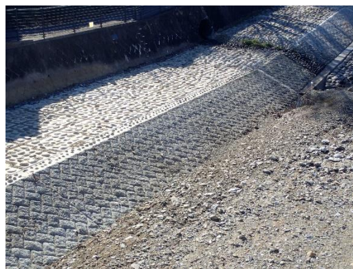
コンクリートブロックで施工された低水護岸、植物は全く生えません
