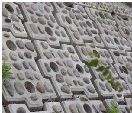
2021年までの落差工の高水敷ブロック
