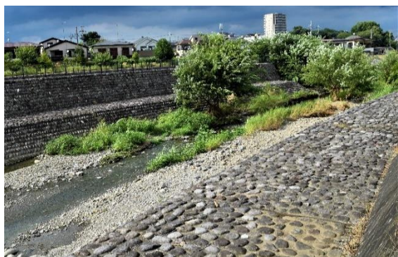
石とコンクリートの高水敷と護岸
