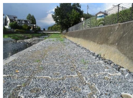
2022年度落差工の凹凸のない高水敷
