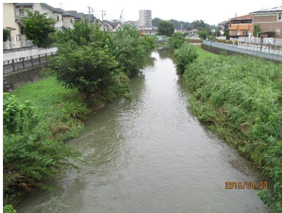
新合流工事前の空堀川下流
