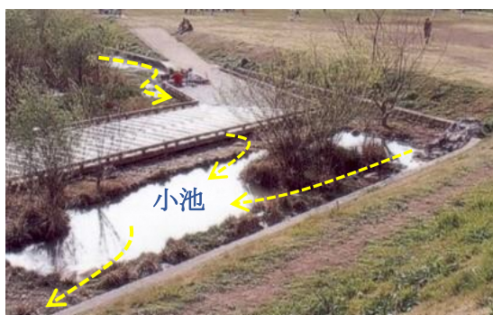
乾性化した箇所の水面化と水路整備
