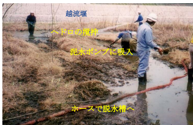
中池と越流堰内側の浚渫(2000. 11～2001. 3)
