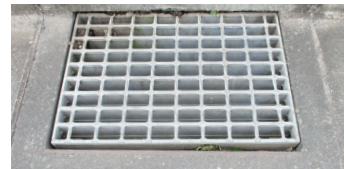
綺麗な状態の雨水ます
