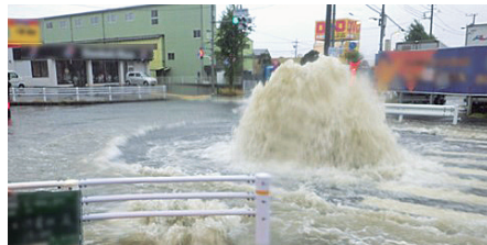
マンホールからの噴出
