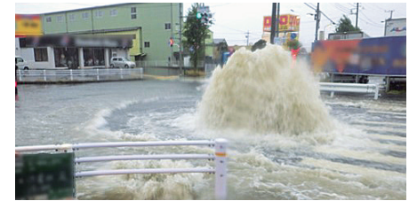
マンホールからの噴出
