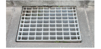
綺麗な状態の雨水ます
