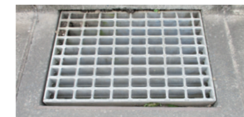
綺麗な状態の雨水ます
