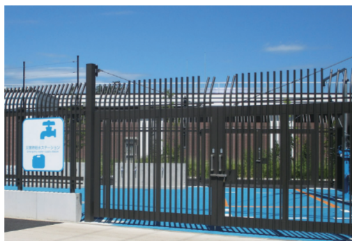
令和4年7月1日災害時給水ステーションとして指定された清瀬梅園給水所
