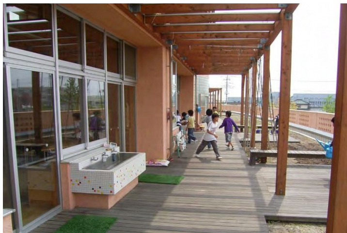
教室前に作業テラスを設けた事例
