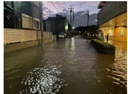
市内で発生した道路冠水の様子
