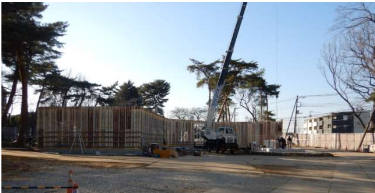
1 階壁型枠を建て込んでいます。
