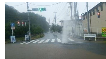
図 マンホールからの噴出 (出典：清瀬市HP)
