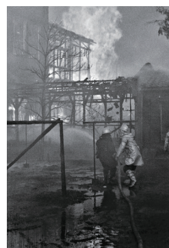
国立療養所東京病院清瀬病棟火災現場(昭和45年撮影)
