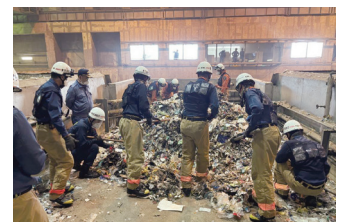
クリーンポート火災現場
