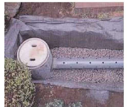
浸透ます施工状況
