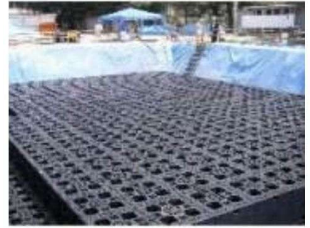
貯留浸透施工状況
