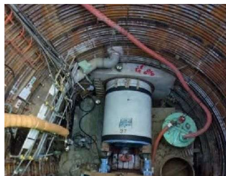
雨水管施工状況
