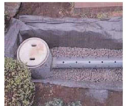
浸透ます施工状況
