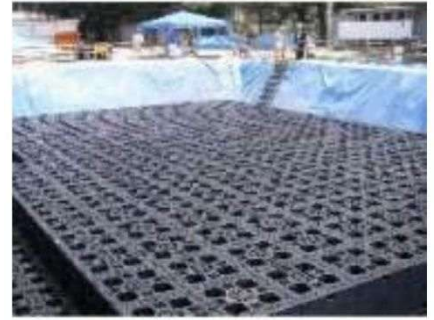
貯留浸透施工状況
