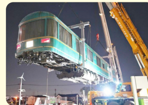
令和7年(2025年)1月 「夢空間」車両を陸送・設置。
