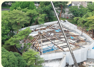
令和7年(2025年)6月 鉄骨屋根組み、屋根のデッキプレートを設置。
