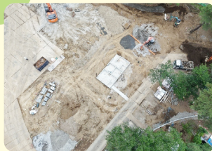
令和8年(2026年)5月 公園トイレの基礎が完成。
